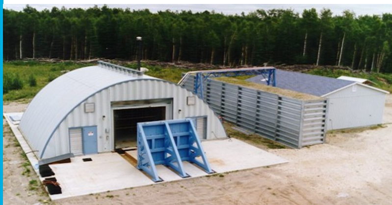
Installation d'analyse de combustion à grande échelle avec ouverture d'aération aux Laboratoires nucléaires canadiens.
